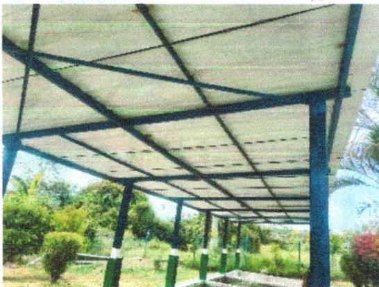
Reemplazo de estructura que conforma el patio de lechos de secado
