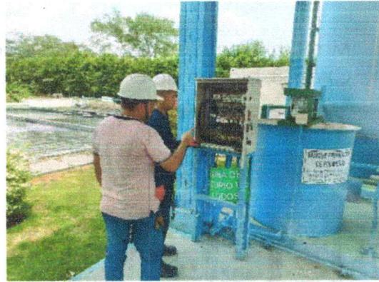
Conexión del sistema de tratamiento de lodos al tablero de control
