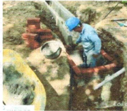
Construcción de caja e instalación de tubería de 8" para la descarga de los cárcamos en Villa Carolina 2
