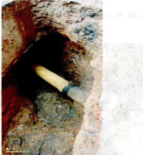
**Foto 19.** Tramo de tubería reemplazado
