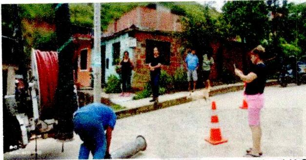
Foto 10. Limpieza de red sanitaria con equipo VACTOR
