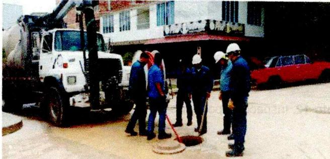
Foto 9. Limpieza de red sanitaria con equipo VACTOR
