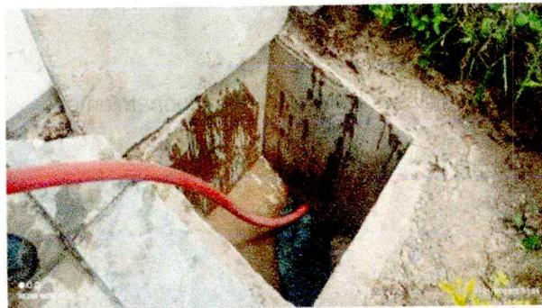
Foto 11. Uso de equipo vactor para limpieza en red.
