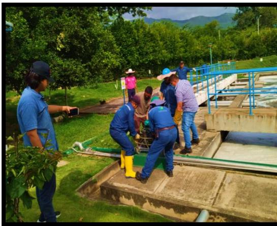
Optimización, mantenimiento, reparación y puesta en funcionamiento de los 4 aireadores para los reactores de la PTAR Ciudadela Nuevo Girón.
