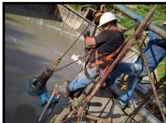
Optimización, mantenimiento, reparación y puesta en funcionamiento los 4 aireadores para los reactores de la PTAR Ciudadela Nuevo Girón.
