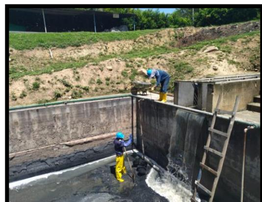
Extracción de arenas y material sedimentado en el pozo de homogenización PTAR
