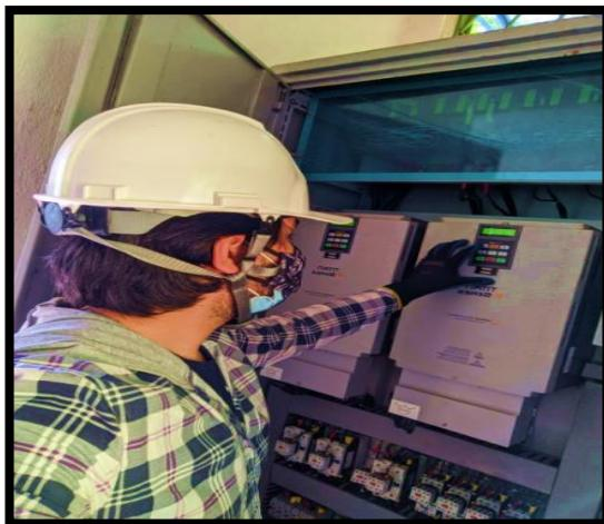
Reprogramación del tablero de control de acuerdo con los parámetros requeridos por los equipos electromecánicos existentes en la PTAR Ciudadela nuevo Girón.
