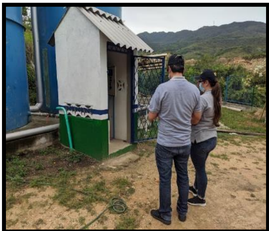
Junto a empresas profesionales, se evalúan mejoramientos de los equipos electromecánicos de la planta.
