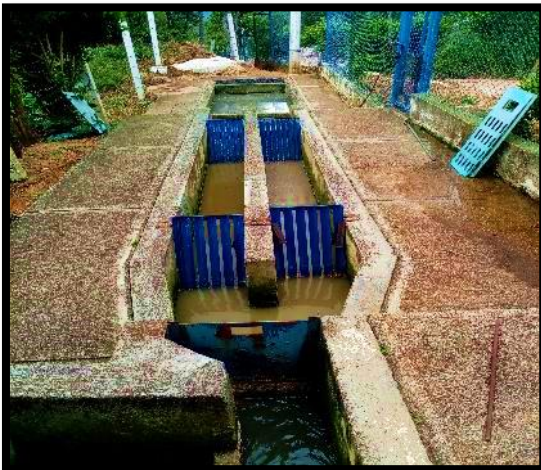
Se realiza mantenimiento e instala cribas metálicas las cuales mejoran los procesos de limpieza en el tratamiento primario PTAR Acapulco.
