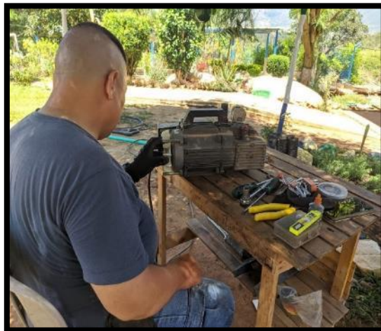
Diagnósticos de daños ocurridos en equipos electromecánicos de la PTAR Ciudadela Nuevo Girón.
