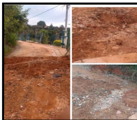
Se realiza mantenimiento al sendero de la entrada a la PTAR.
