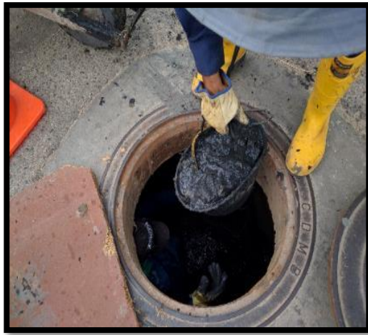
Se realiza limpieza manual de sumideros en diferentes sectores.
