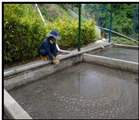
Descarga en los lechos de secado.
