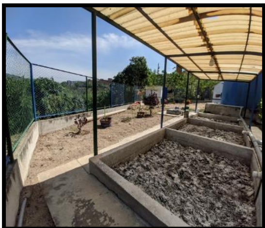
Se realizan actividades operativas con fin de garantizar el correcto funcionamiento de la planta.
