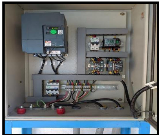
Se realiza mantenimiento a los sistemas de control y automatización, estableciendo una correcta configuración, limpiando y ajustando bien sus puntos de conexiones.
