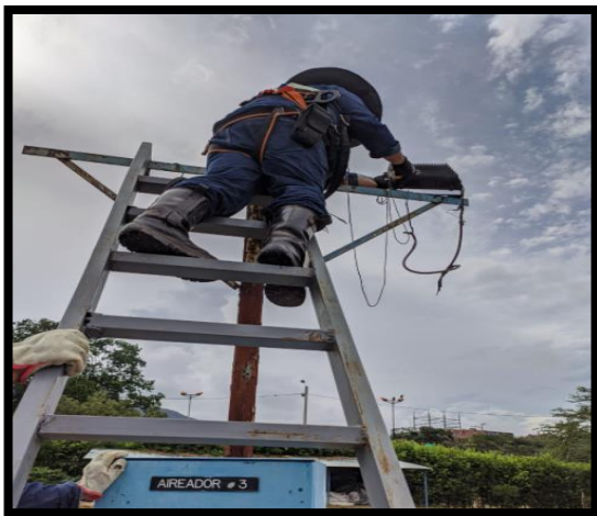
Reposición de luminarias PTAR Nuevo Girón.
