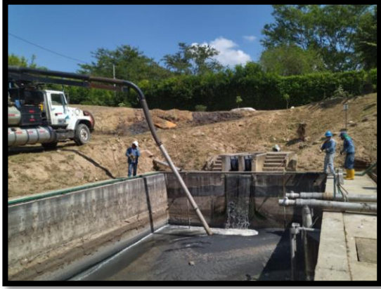
Extracción de arenas y material sedimentado en el pozo de homogenización PTAR Nuevo Girón.
