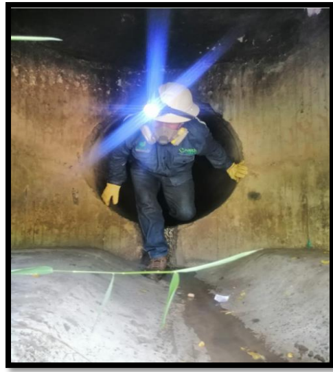
Inspección de colectores y estructuras de separación en redes de alcantarillado para la formulación y gestión de nuevos proyectos de inversión.
