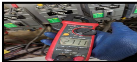
Medición de consumos energéticos para cada uno de los equipos operativos dentro de la PTAR Ciudadela nuevo Girón.
