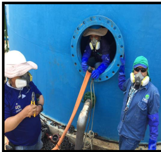
Reparación de malla retenedora, limpieza de rosetones y ductos de aireación, del reactor UASB PTAR Acapulco
