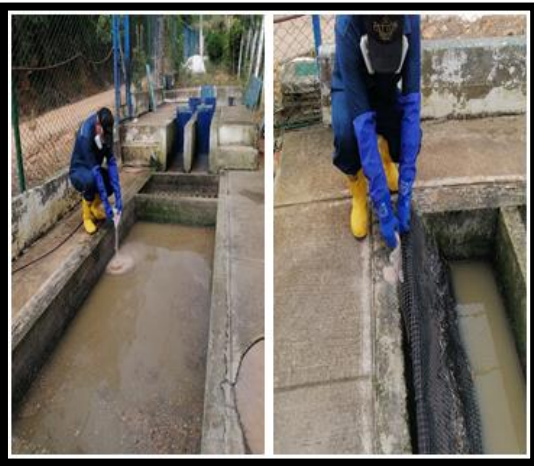
Aplicación de nuevas tecnologías químicas de bacterias digestoras para mejorar los parámetros de tratamiento en la PTAR Centro poblado Acapulco.
