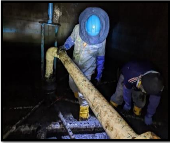
Se realiza atención a contingencia por daño y mantenimiento del reactor UASB y sedimentadores dentro del tratamiento secundario PTAR Acapulco.
