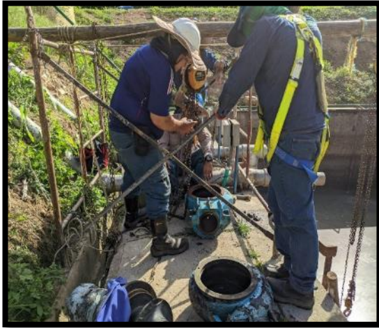
Se realiza diagnóstico y mantenimiento de maquinaria de bombeo.
