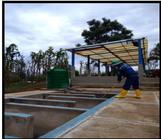
Aplicación de nuevas tecnologías químicas de bacterias digestoras para mejorar los parámetros de tratamiento en la PTAR Centro poblado Acapulco.
