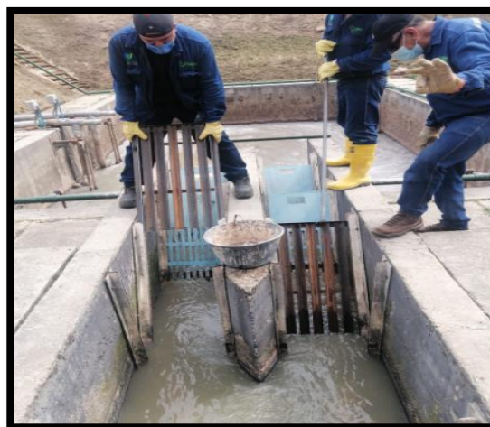
Fabricación de rejillas en Angulo metálico para mejorar los procesos de
