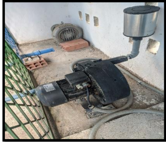
Se realiza mejoramiento a la maquinaria operativa.
