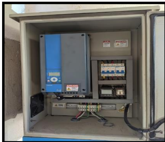
Se realiza evaluación periódica del estado de los equipos de automatización y control.
