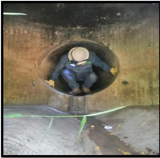
Inspección de colectores y estructuras de separación en redes de alcantarillado para la formulación y gestión de nuevos proyectos de inversión.
