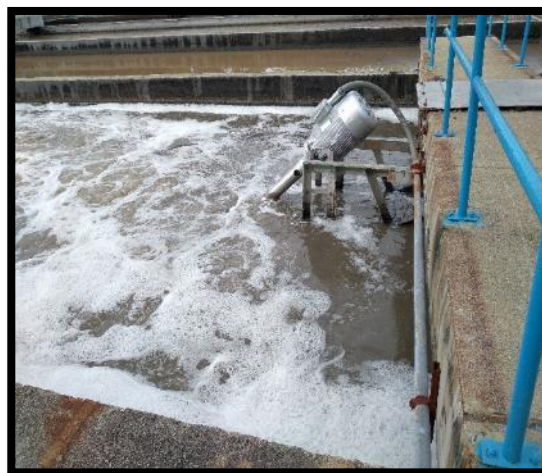
Reparación, pintura y puesta en funcionamiento de aireadores en la PTAR Ciudadela nuevo Girón.
