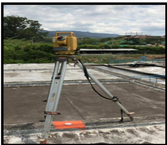
Fabricación de Mojones y Levantamiento Topográfico de la PTAR Ciudadela
