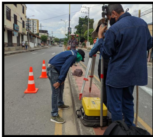
Actividades de topografía y diagnóstico de redes de alcantarillado existentes para la formulación y gestión de nuevos proyectos de inversión.
