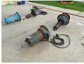
Inspección de electrobombas homogenización
