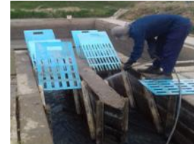
Cribas de desbaste reparadas
