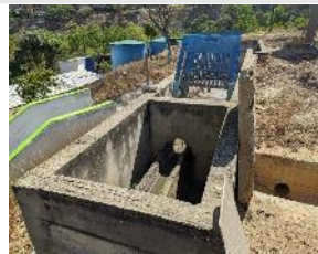
Limpieza de cribas del sector primario.
