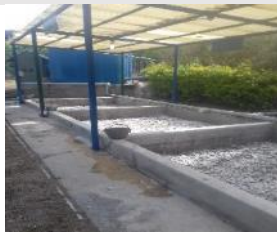
Mantenimiento preventivo lechos de secado
