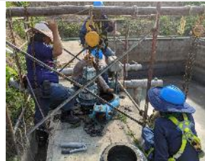
Mantenimiento correctivo electrobombas en Homogenización.
