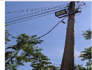
Fallo de luminaria.
