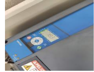
El variador es de 5hp, no cumple con los requisitos para soporte de maquinaria de trabajo pesado.
