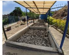
Lechos de secado no cuentan con llaves de descarga.
