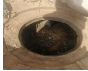
Pozo de inspección colapsado de material de arrastre
