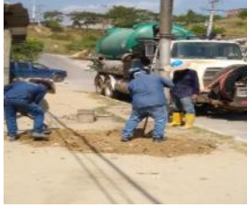
Mantenimiento de pozos
