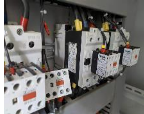
Falta de elementos de accionamiento
