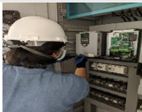
Mantenimiento preventivo tablero principal de control.
