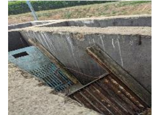
Mal estado del cribado en el sector primario uno.
