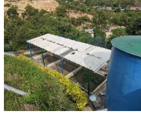
Techo de lodos en mal estado.
