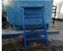
Escalera tanque agitador reparada
