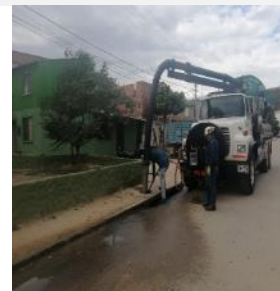
Inyección de agua a presión para soltar sedimentos secos
