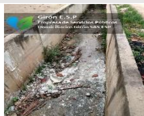
Mal estado de canaletas en nuevo girón, por múltiples concentraciones de residuos, sector 5.
