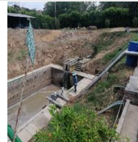
Cribas de desbaste reparadas
