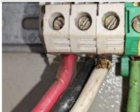
Mal estado de puntos de conexión eléctricos.
