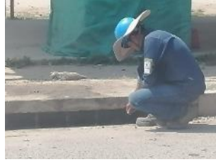
Instalación de malla retenedora en sumideros
