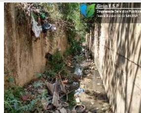
Mal estado de canaletas en nuevo girón, por múltiples concentraciones de residuos, sector 5.
