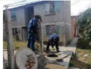
Inyección de agua a presión para soltar sedimentos secos
