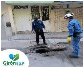
Inspección de pozos.
