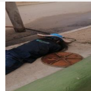
Limpieza de sumideros de aguas lluvias
