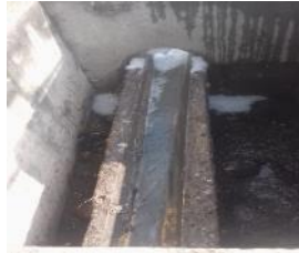
Limpieza de entrada de afluente
