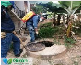
Fumigación de pozos en villa del sol.
