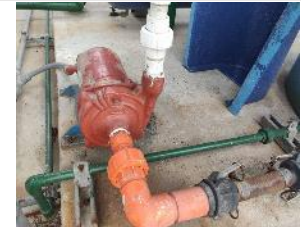
Mantenimiento correctivo electrobomba autocebante por atascamiento.
