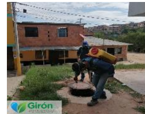
Fumigación de pozos en villa del sol.
