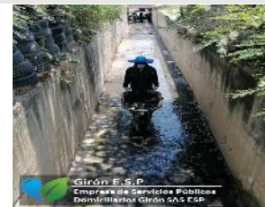
Limpieza de canaletas en sector 5 de nuevo girón, 160 metros lineales.
