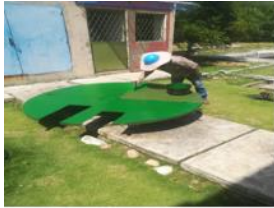
Tapa pozo de alivio reparada
