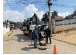
Retiro de material de arrastre de pozos
