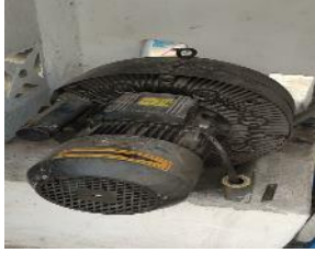
Equipo Blower fuera de servicio.
