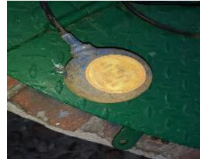
Mal estado de elementos de accionamiento, interruptor de nivel.
