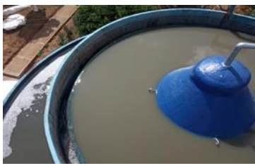
Colapso de bajante anaerobio a aerobio
