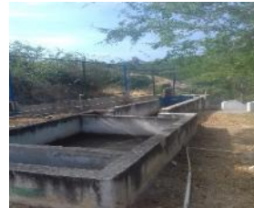
Mantenimiento de trampa de grasas
