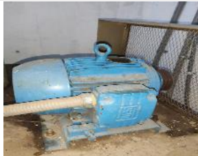
Falta de equipo Blower, para correcta realización de aireación.
