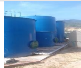
Pintura de tanques aerobio y anaerobio
