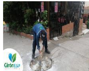
Inspección de pozos
