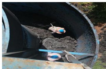
Rompimiento de malla retenedora de biodiscos aerobio
