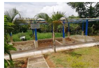
Lechos filtrantes incompletos
