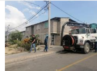
Limpieza de sumideros de aguas lluvias
