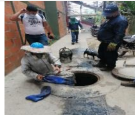
Limpieza Manual de pozo de inspección
