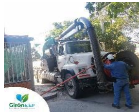
Retiro de material de arrastre de pozos
