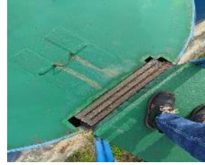
Superficies en estado de oxidación.
