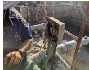
Mantenimiento correctivo sistema de cableado electrobombas de Homogenización.
