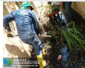
Limpieza de canaletas en sector 5 de nuevo girón, 160 metros lineales.
