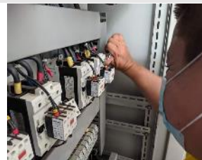
Correcto ajuste de puntos de conexión y limpieza de acometidas eléctricas.
