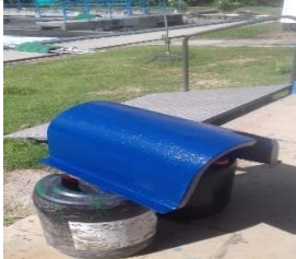
Trabajos de pintura en la PTAR CNG.
