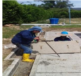
Instalación de tapas en los sedimentadores.
