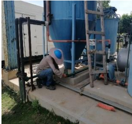
Fijación de canaletas de desnate en sedimentador 1.
