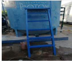
Escalera tanque agitador reparada
