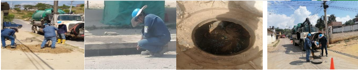
Mantenimiento de pozos
