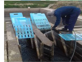
Cribas de desbaste reparadas
