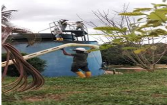
Instalación de nuevo bajante anaerobio a aerobio
