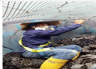
Tejido de malla retenedora de biodiscos aerobio
