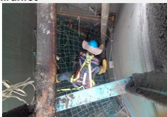
Se teje refuerzo con laso para evitar rompimiento de malla contenedora
