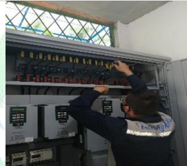
Reemplazo de puentes de contacto del barraje al variador de velocidad de motores de 40HP.
