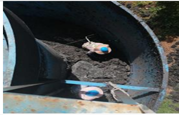
Rompimiento de malla retenedora de biodiscos aerobio
