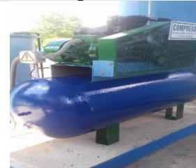
Trabajos de pintura en la PTAR CNG.
