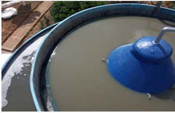
Colapso de bajante anaerobio a aerobio
