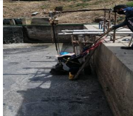
Extracción de la electrobomba sumergible No 1 de 10HP en el pozo de homogenización.
