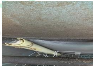
Instalación de nuevo bajante de 6"
