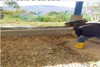
Adecuación de gravilla para filtro frances
