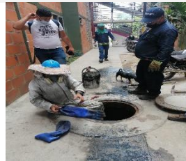
Limpieza Manual de pozo de inspección
