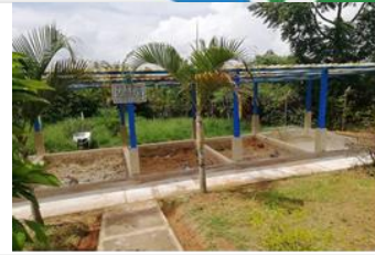
Lechos filtrantes incompletos
