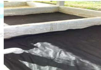
Instalación de geotextil a Lechos filtrantes
