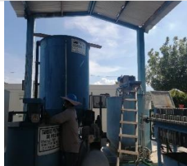
Pintura de soporte de los motores del agitador de lodos y polímero.
