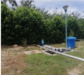
Pintura de tubería de pozos de expulsión de la cámara de aforo con alumol para su protección térmica.
