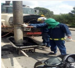
Retiro de material inservible y arrastre de pozo
