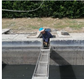
Fijación de canaletas de desnate en sedimentador 2.
