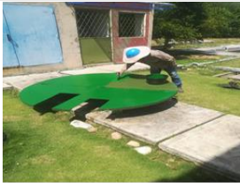
Tapa pozo de alivio reparada
