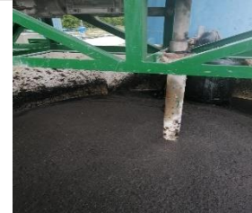
Transferencia de lodos en el concentrador al agitador de lodos.
