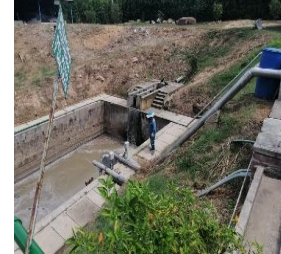
Pintura de tubos de transferencia del pozo de homogenización.
