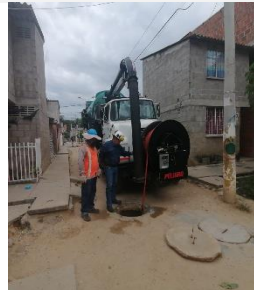
Labor de dagrado en tubería sanitaria sector 5 manzanas E y F de Ciudadela Nuevo Girón.
